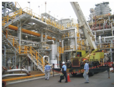
(現場吊掛作業檢查)
